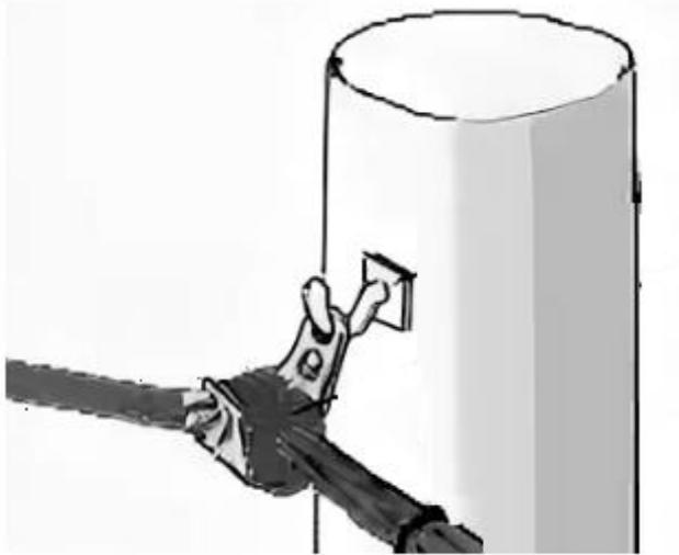
**Запрещено применять данные зажимы для проводов без изоляции!**
